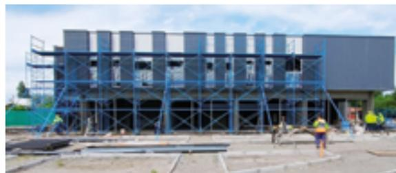
En noviembre de 2023, se inició la faena del Edificio de Uso Mixto Bulnes, consistente en una construcción de dos niveles equivalente a una superficie de 640,30 M<sup>2</sup>, con una estructura para los locales comerciales de albañilería reforzada de 296,23 M<sup>2</sup>. El Centro Médico tiene una superficie de 344,07 M<sup>2</sup>, segundo piso, y estructurado en losa de hormigón armado, muros y techumbres de estructura metálica y metalcom, más ascensor.
